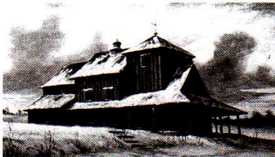
Зруйнована церква в с. Журавин
